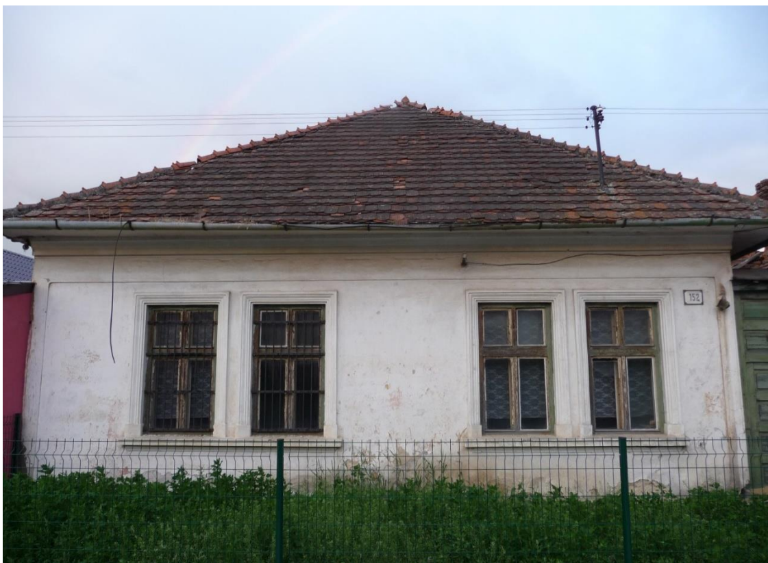
Obr. 10 Modrotlačiariska dielňa – Predný dom, pred rekonštrukciou – 2015 (foto: Adam Benko)
