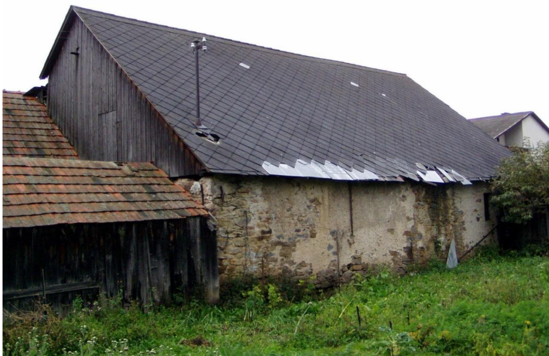
Obr. 12 Modrotlačarska dielňa – stodola s mangľom – 2015 (Foto: Adam Benko)
