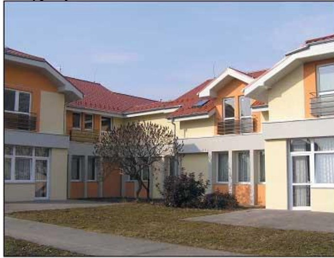
Obr. 2. Nadstavba materskej škôlky
